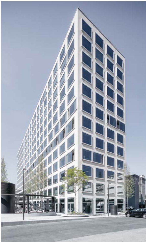
苏黎世 Diakonie Bethanien 医疗大楼 高度：40米 推拉扇：500 特色：完整的幕墙立面
