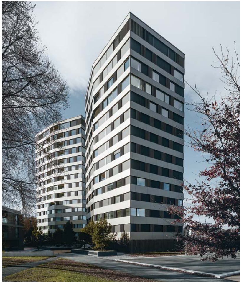
卡姆 One-One 塔楼 高度：46和49米 推拉扇：58 特色：完整的幕墙立面
