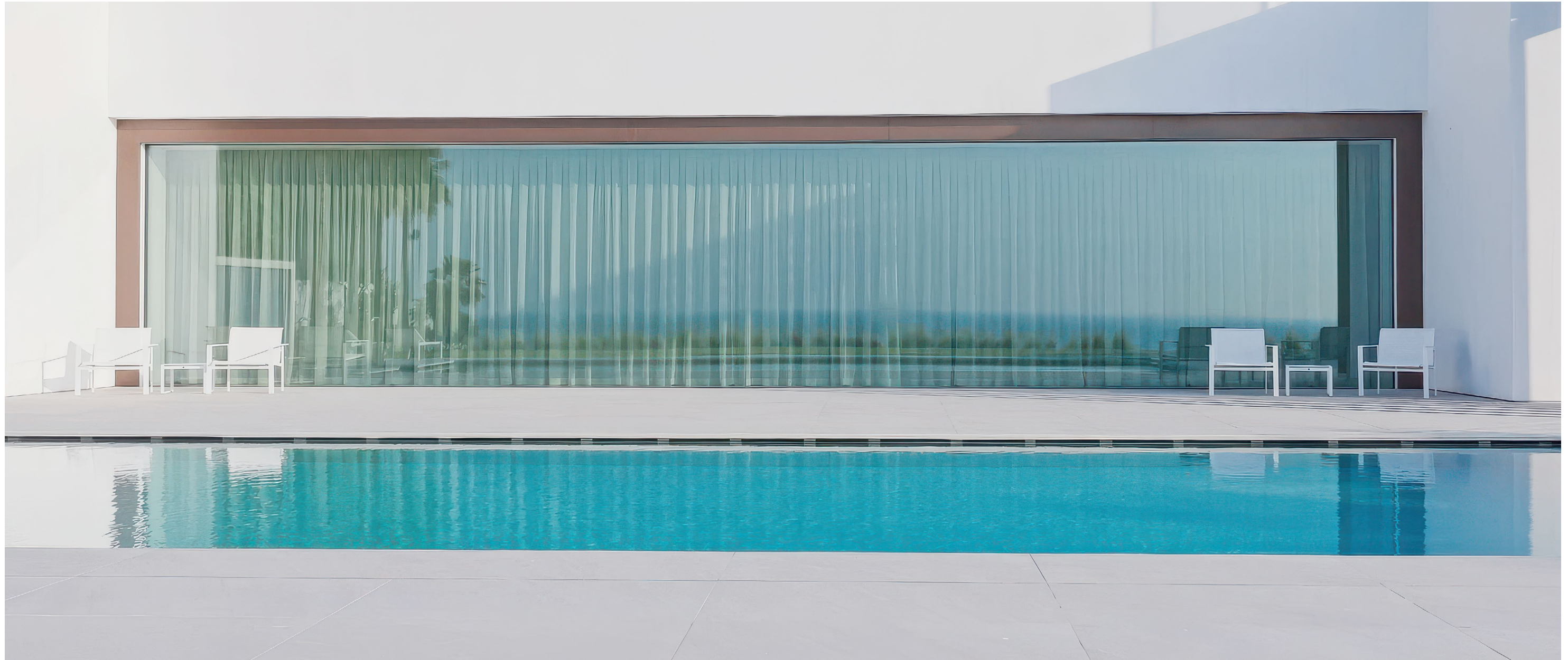
Das grösste Senkfenster der Welt mit einem 3-fach Isolierglas mit 16m Breite und 2.8m Höhe. Das Glasgewicht beträgt 7500kg.
