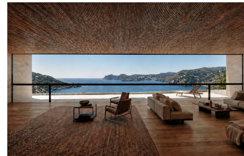
16.5m langes Senkfenster mit zwei integrierten Schiebefenstern
