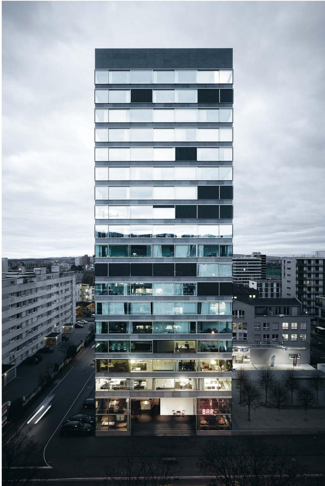
Ein schönes Beispiel für Architektur mit air-lux ist das 40 Meter hohe, zwölfgeschossige Hochhaus an der Buckhauserstrasse 34–36 in Zürich. Die raumhohen air-lux Fenster sind wie Bilderrahmen auf die Sichtbetonfassade aufgesetzt. Die Schiebefenster fahren ausserhalb des Gebäudes. Der Architekt Piet Eckert wollte mit den Fenstern ein repetitives Muster schaffen, das sich mit dem Öffnen der Fenster organisch verändert. Eine Herausforderung, die wir mit Begeisterung angenommen haben.
